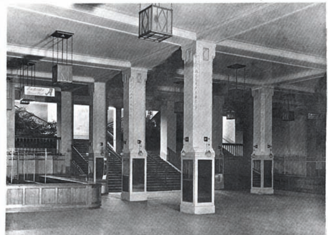
Abb. VIII.8: Ludwig Baumann und Ferdinand Fellner & Hermann Helmer, Wiener Konzerthaus, Kleiner Saal und Garderobehalle des großen Saales mit Haupttreppe, 1910–1913 (aus: Allgemeine Bauzeitung 79 [1914], Tafel 34).
